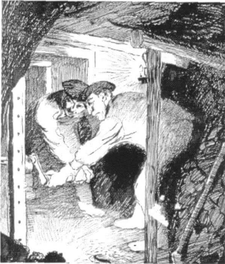
▲ Bohren eines Sprengloches (Bayer/Schuster 1988, S. 118)
